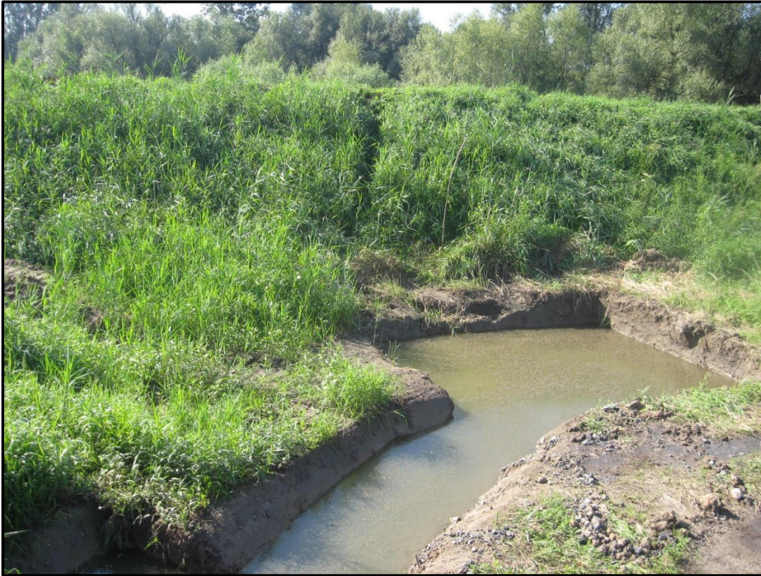
Fot.10. Wykop pod fundament śluzy wałowej. Do wykopu sphywała woda z sąsiadującego obszaru.(Fot. arch.)
