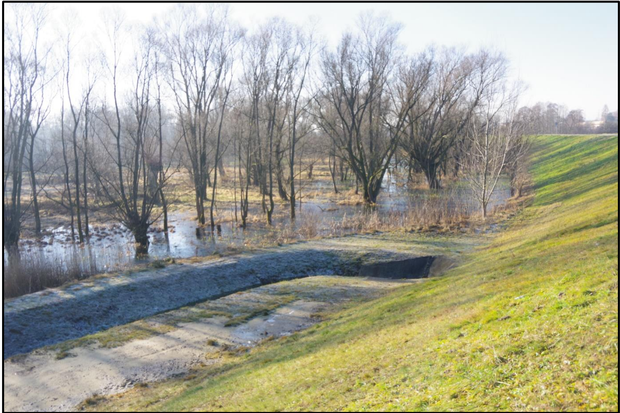
Fot. 1. Śluza wałowa od strony międzywala.
