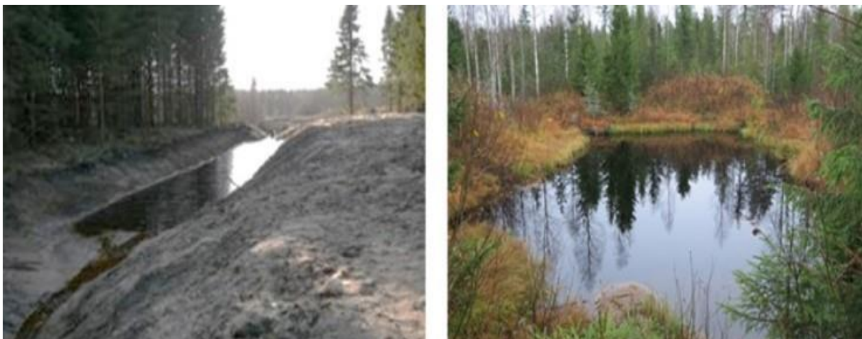
Fot. 14. Po lewej nowo wybudowany staw sedymentacyjny na Łotwie (zdjęcie: Zane Lībiete), po prawej 20-letni staw sedymentacyjny w środkowej Finlandii. Zdjęcie: Tommi Tenhola.
