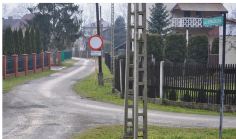
Jednym z zadań, które znalazło się na liście podstawowej jest przebudowa ul. Strażackiej w Brzezince. Fot. lor
